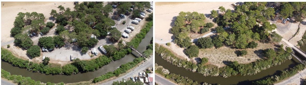
Renaturation de la zone de stationnement – photos avant/après travaux. Source : Loomastar
